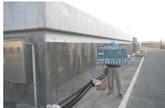
濃縮槽天端RC補強梁設置
