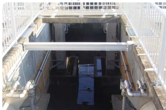
排水渠耐震補強梁設置
