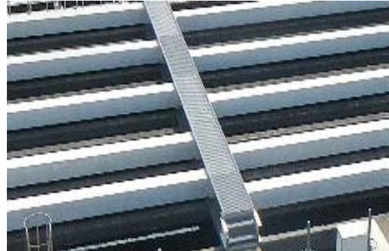
沈でん池天端PC補強梁設置
